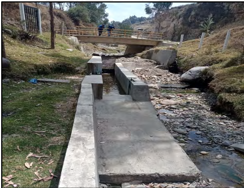
Construcción actual de captación de agua (Fuente :Emapa)
