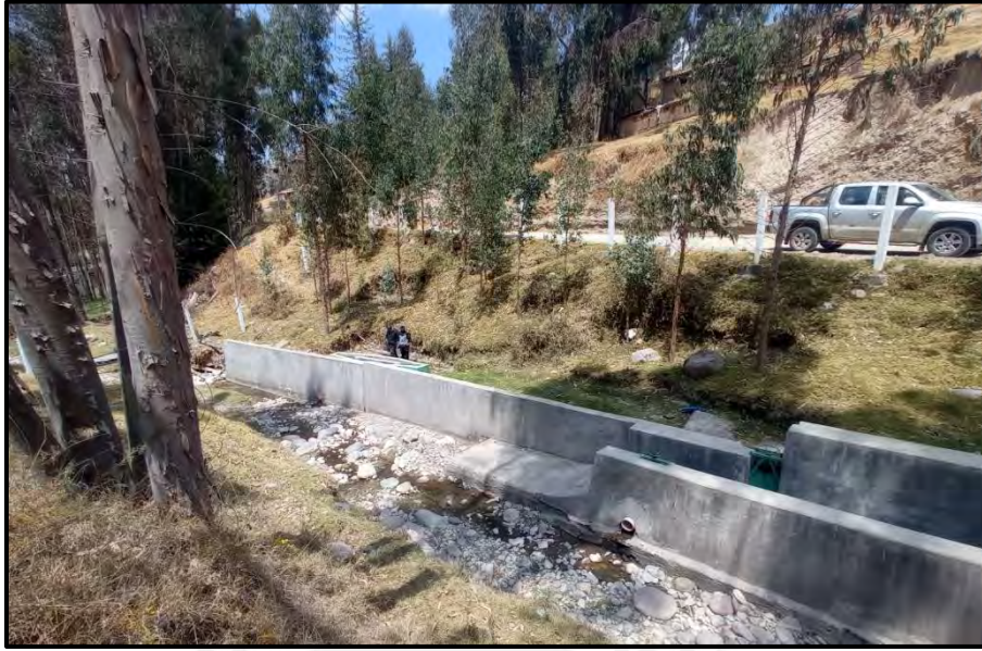
Construcción actual de captación de agua (Fuente :Emapa)
