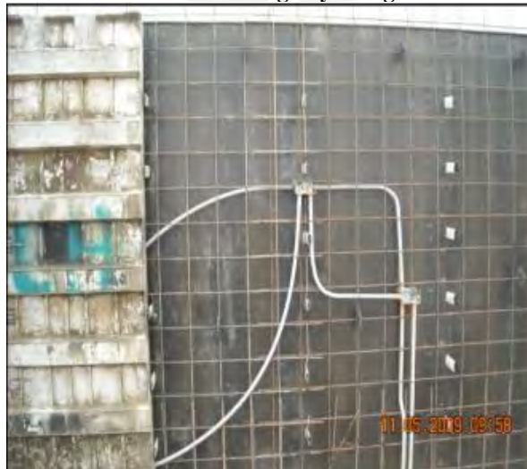
Ilustración 76. Tuberías de agua y desagüe embebidas en muro
