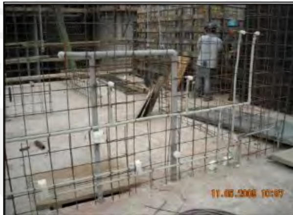
Ilustración 75. Tuberías de agua y desagüe embebidas en muro
