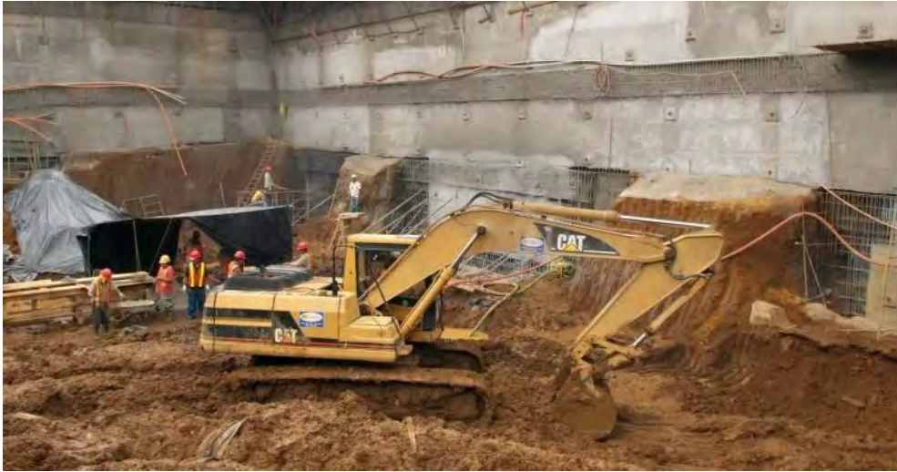
Figura 2 Movimiento de Tierra o excavación.
