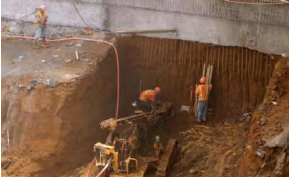
Figura 4 Perforación y anclaje de cable tensor.
