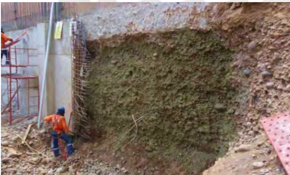
Figura 3 Perfilado y pañeteo de banquetta.
