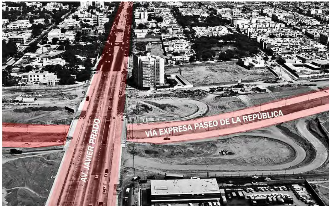
Gráfico N°09: Fotografía de San Isidro. Vía Expresa en construcción. Cerca de 1965.
