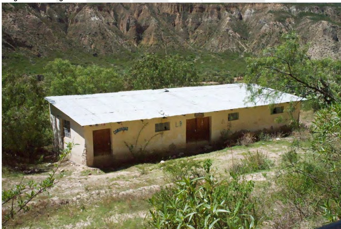
Figura 37 Antigua casa del guardián de la mina
