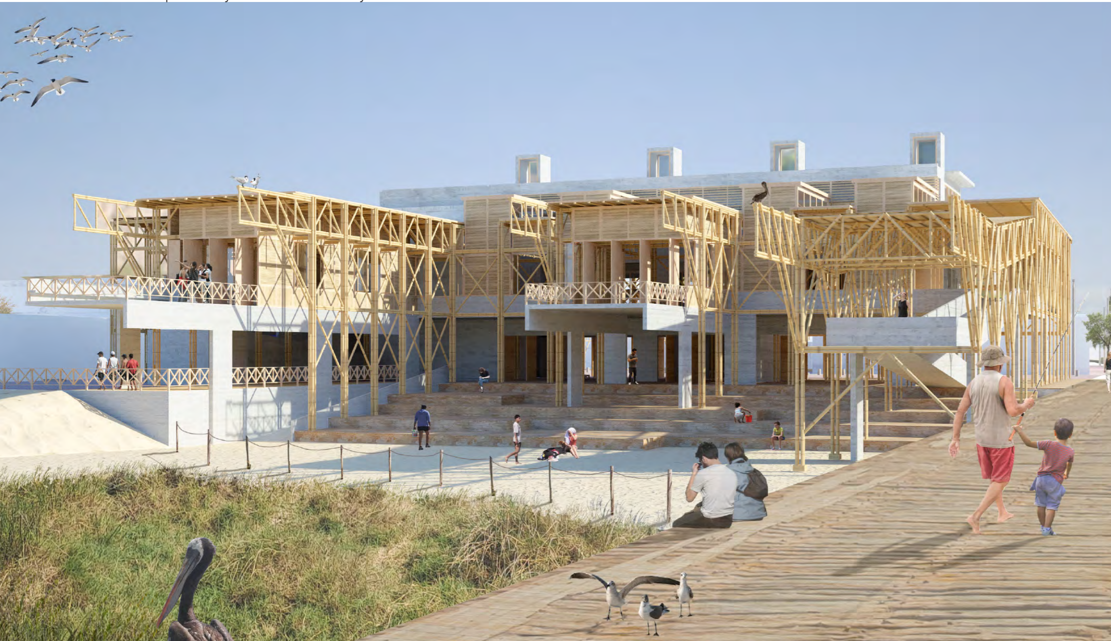
Vista del proyecto desde el muelle / Proyecto
