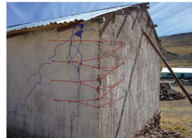
Fotografía de sosten de muro con cuerda y palo Foto: Sofía Rodríguez Larrain
