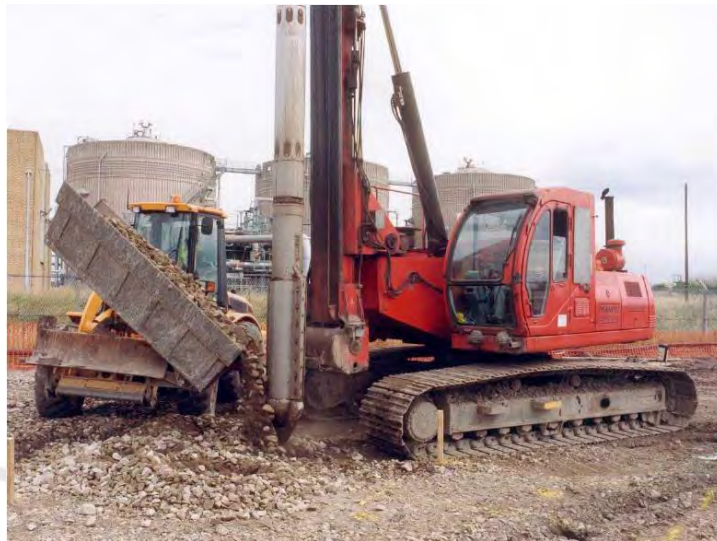
Figura 21. Vista general del tratamiento de terreno con columnas de grava.
