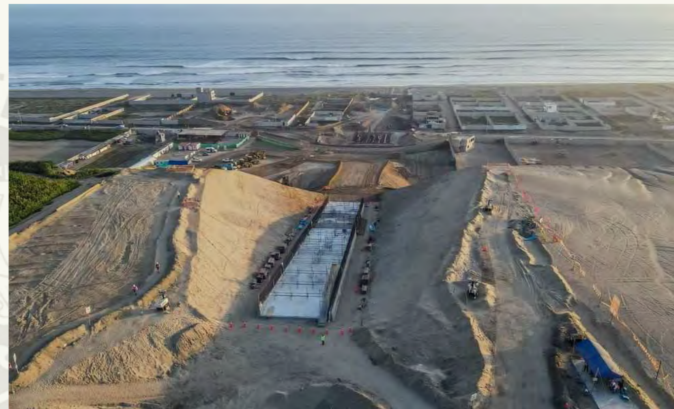
Construcción de la desembocadura del canal 1 Fuente. ARCC, 2023
