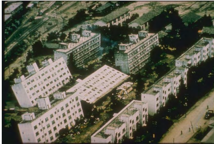
Figura 12. Daño inducido por licuación tras el terremoto de Niigata en complejo residencial de Kawagishi-cho, 1964. Fuente: Base de datos de NOAA, NGDC.
