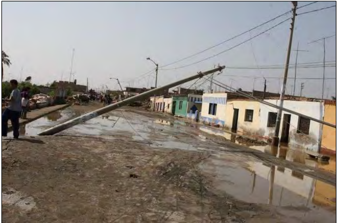
Figura 3.6.4 Caída de poste en el distrito de Pisco tras el terremoto del 2007
