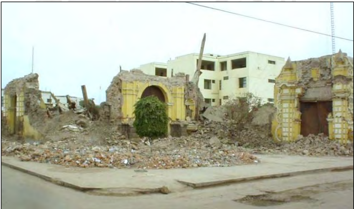
Figura 3.6.2 Vista frontal de la iglesia La Compañía después del terremoto
