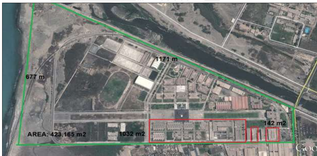
Figura 10: Instalaciones del CITEN 13 .
