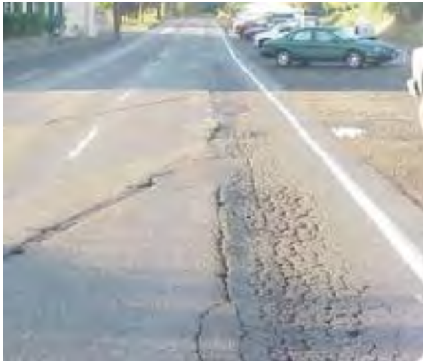
Figura 3. Piel de cocodrilo acompañada de ahuellamiento. Fuente: Diseño con geosintéticos. Pavco Wavin (2021).
