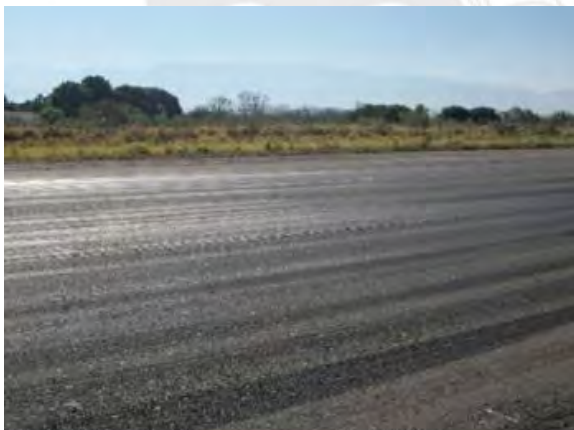
Figura 4. Ahuellamiento. Fuente: Diseño con geosintéticos. Pavco Wavin (2021).
