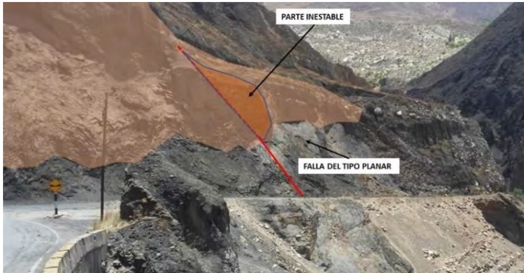
Figura 2.7. Panorámica del sector inestable 2, donde se ubica la falla planar (Estudio geomecánico del proyecto).
