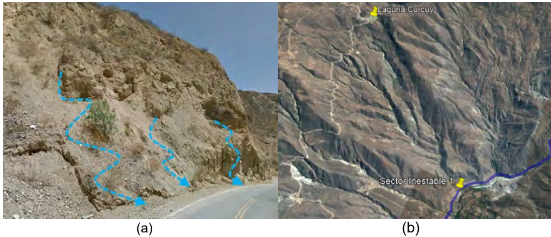
Figura 2.5. (a) Talud donde se evidencia la presencia de flujo y (b) Potencial infiltración debido a la influencia de la laguna Curcuy (Estudio geomecánico del proyecto).
