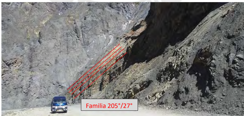
Figura 2.6. Talud Superior, con potencial plano de falla (Estudio geomecánico del proyecto).
