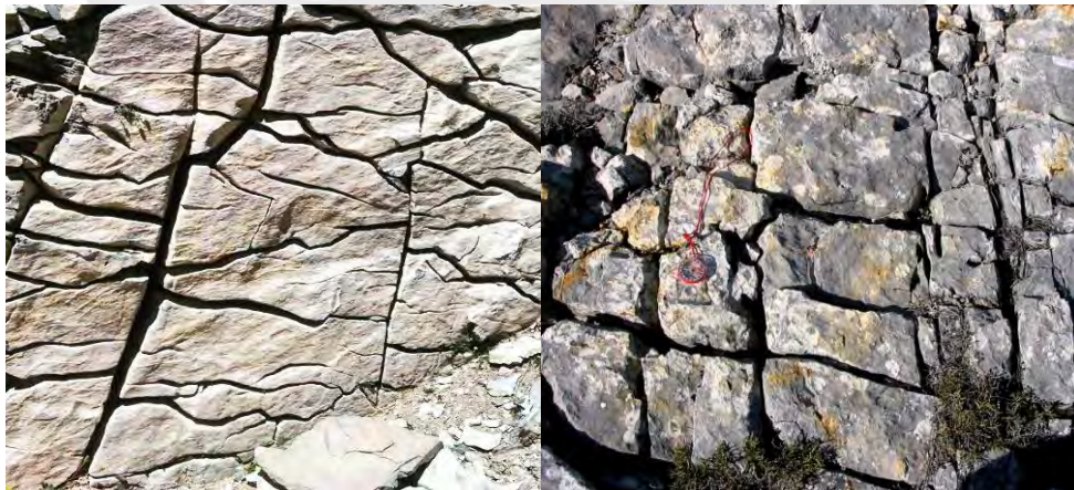
Figura 3.4. Estructura discontinua: Diaclasa (Tomado de www.meteorologiaenred )
