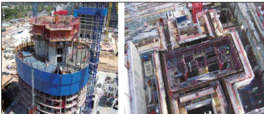
Fig. 4. 4 Empleo del Sistema ATR en núcleos con geometría irregular (ULMA CONSTRUCCION, 2011)
