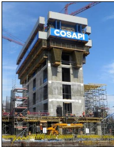
Fig. 2. 20 Desplazamiento de la Plataforma SCP (DOKA, 2016)
