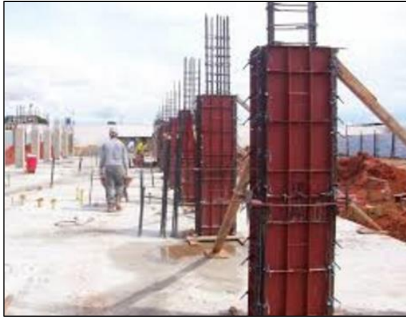
Fig. 2. 4 Encofrado en Columnas (Metal Machine Ecuador, s.f.)
