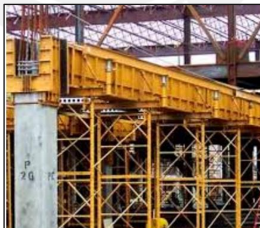
Fig. 2. 3 Encofrado en Vigas (EFCO, s.f.)
