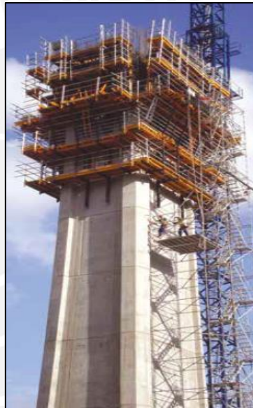
Fig. 4. 2 Sistema ATR en ejecución de pilas (ULMA CONSTRUCCION, s.f.)
