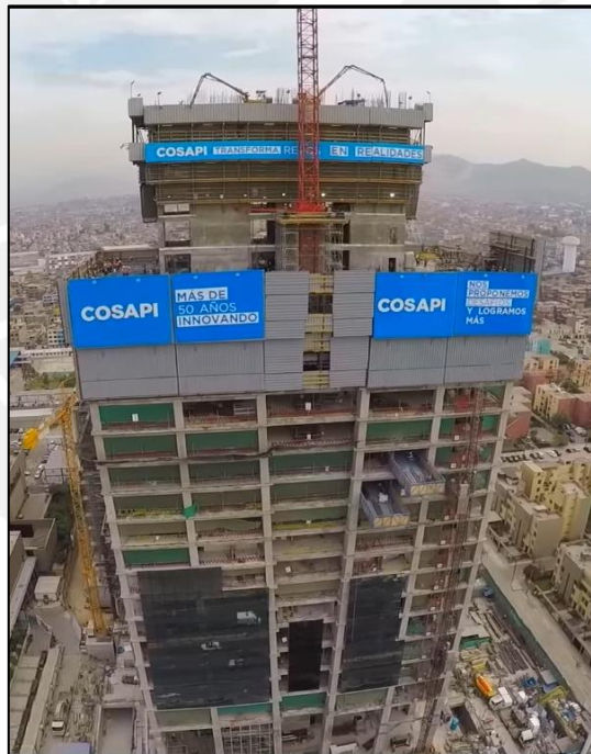
Fig. 4. 5 Seguridad Perimetral en Sistema Autotrepante (CosapiOficial, 2015)
