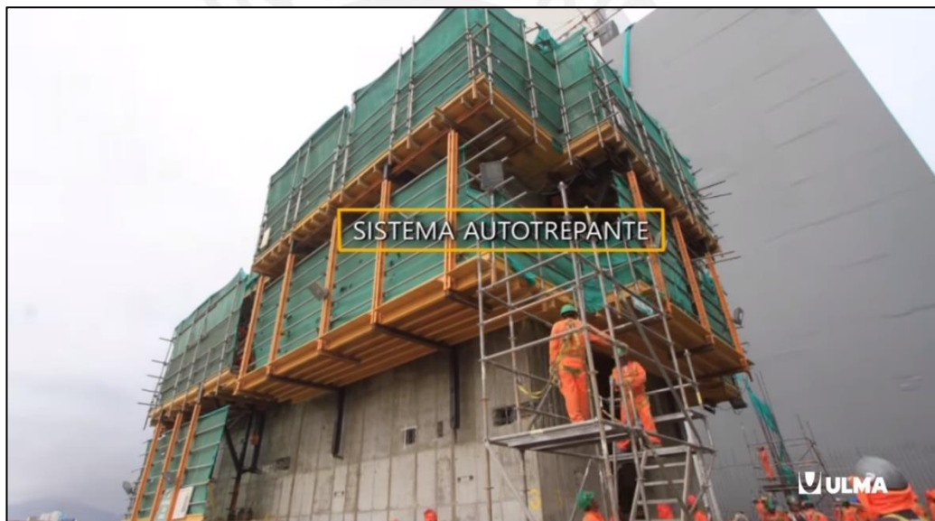
Fig. 2. 42 Sistema Autotrepante Torre Javier Prado (ULMA CONSTRUCCION, 2011)
