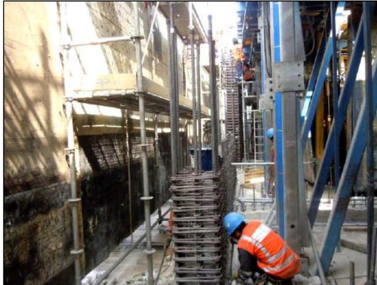
Fig. 2. 25 Amplias áreas de trabajo cubiertas en todo su perímetro (Doka Perú SAC, 2008)
