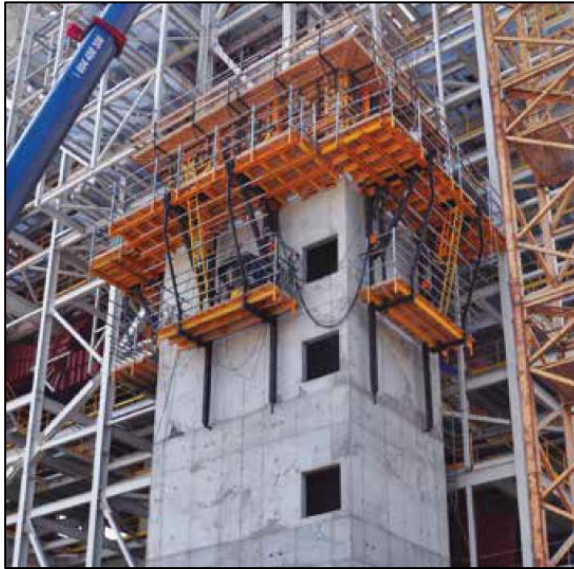
Fig. 2. 11 Típico Sistema de Encofrado Autotrepante para la Construcción de un Muro Central (ULMA CONSTRUCCION, s.f.)
