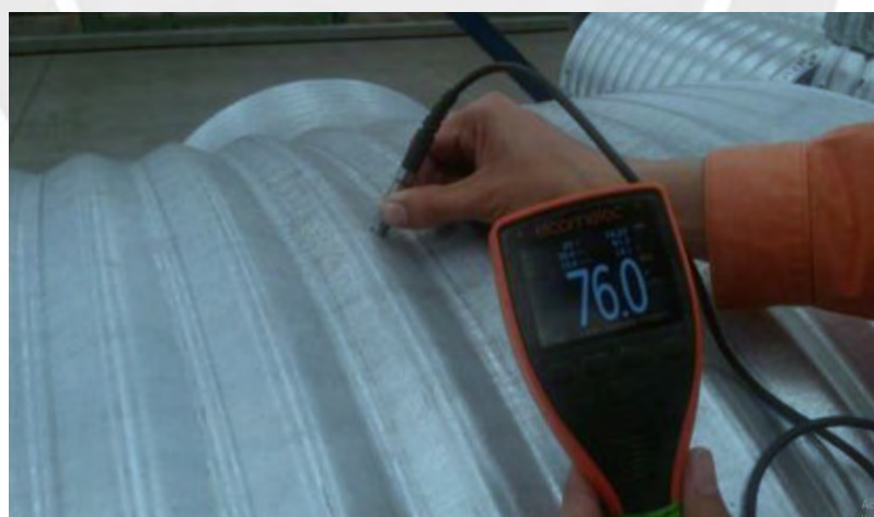
Figura 20. Inspección de espesores.
