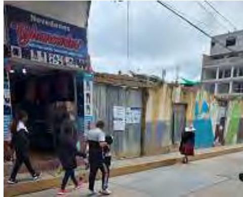
FIGURA N° 4.2: Ancho de vereda más crítica (0.75 m) - Cuadra 6. Fuente: Propia
