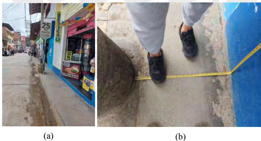
FIGURA N° 4.3: Reducción del ancho de la vereda por poste de luz - Cuadra 7 Fuente: Propia
