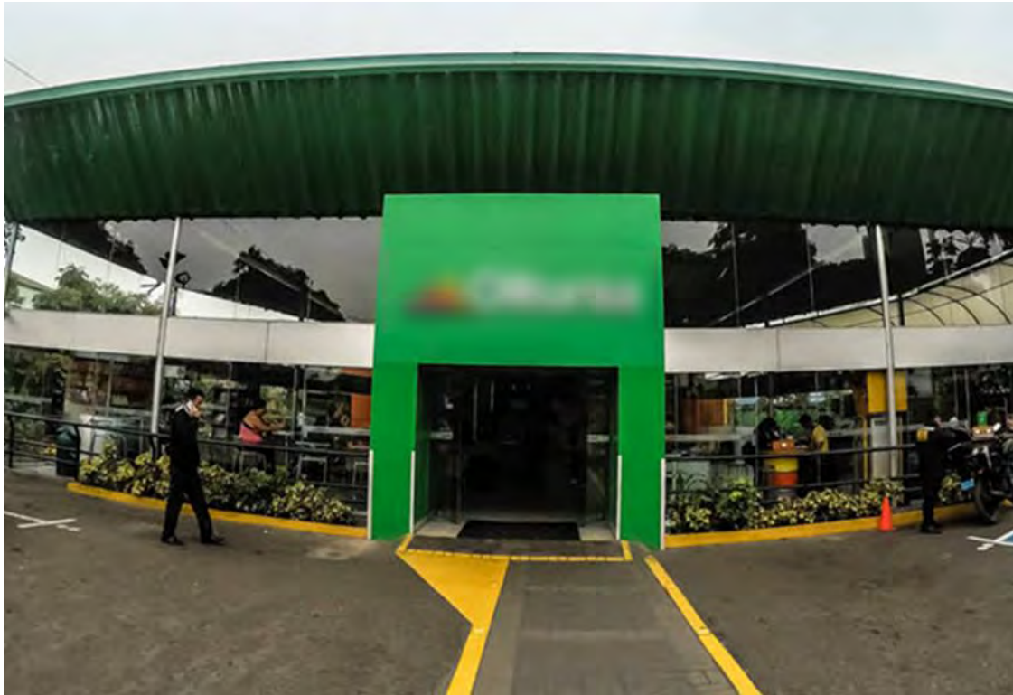
Figura 17. Terminal Terrestre de la Empresa. Fuente: Proporcionado por la Empresa de Transportes
