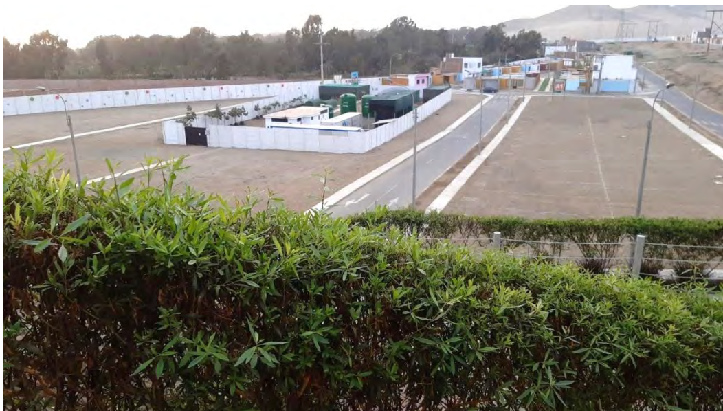
Foto E.1. Zona de pozo y de almacenamiento de agua tratada en Urbanización San Antonio de Mala
