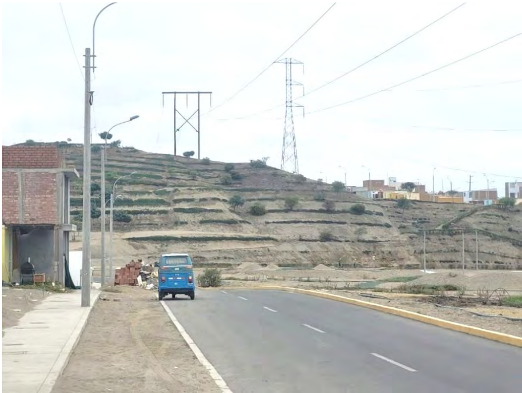
Foto E.8. Urbanización San Antonio de Mala, zona de hondonada, vista hacia la parte alta de urbanización.
