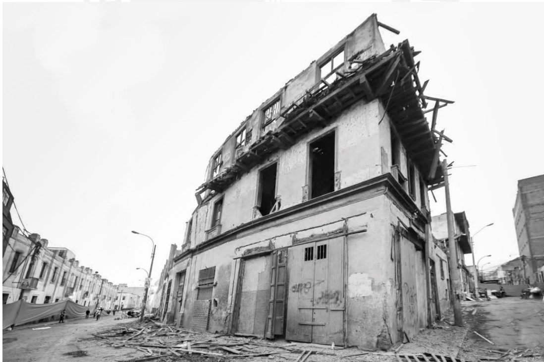
Imagen 2: Fotografía del estado actual del inmueble El Buque.
