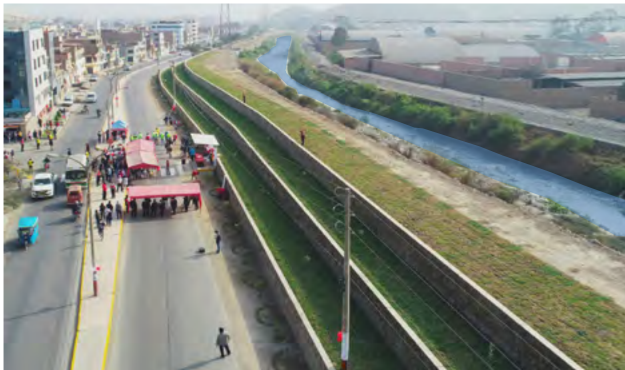
Aterrazamiento en el borde fluvial
