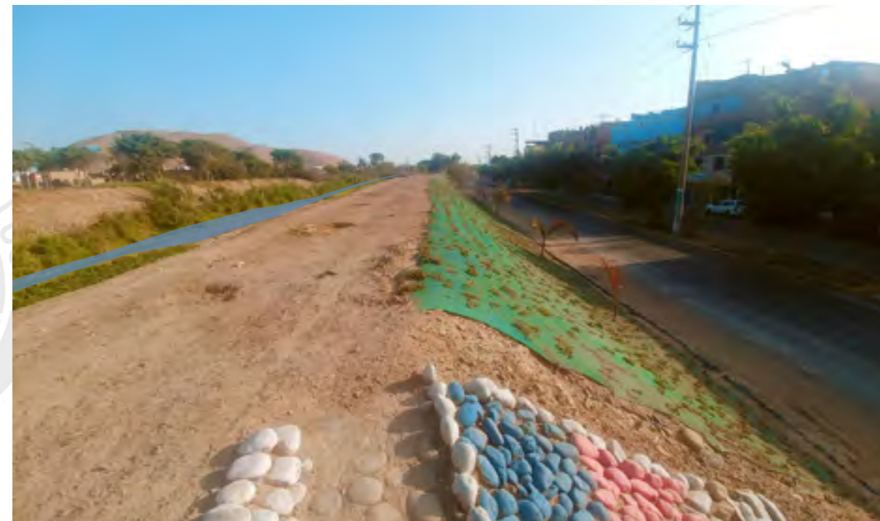
Talud intervenido con malla raschel y vegetación plantada
