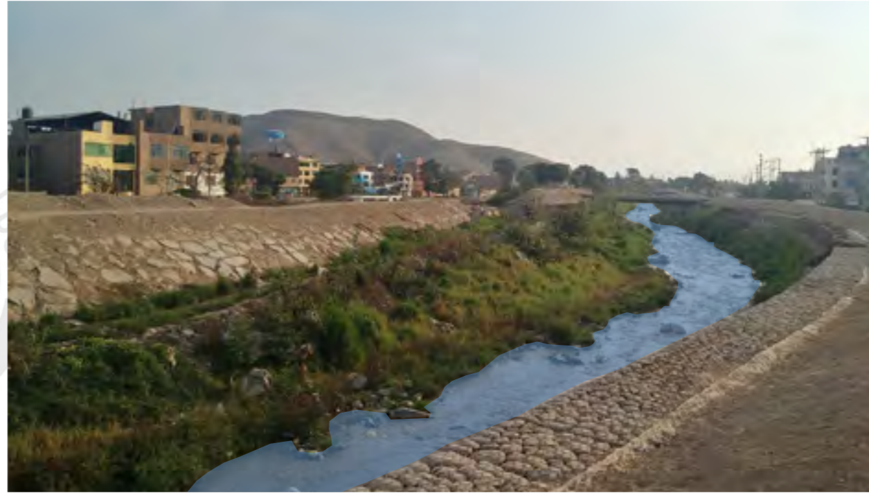
Un margen con enrocado y otro margen con gaviones Fuente: Fotografía propia (2022).
