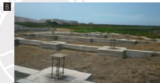
Cimientos de una cafetería inconclusa
