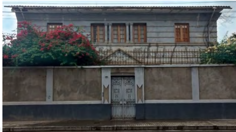
Figura 124: Arquitectura tradicional en el centro de la ciudad
