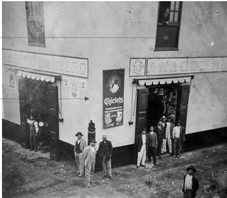
Figura 70: Tipología arquitectónica de la zona comercial -1910
