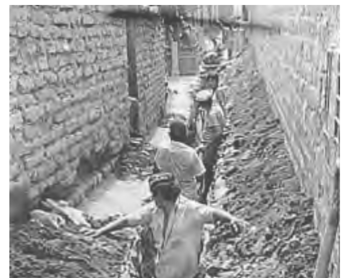
RECOLECCIÓN DE AGUA Y TRABAJO DE ALCANTARILLADO Fuente: Daniel Pajuelo, 1986
