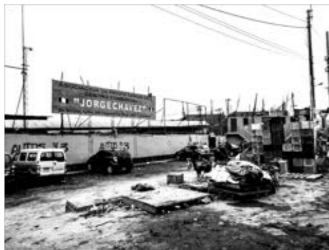
(DE ARRIBA A ABAJO) DEPÓSITOS Y TALLERES, CENTRO DE SALUD MENTAL Y MERCADO Fuente: Google Street View, 2015; Propia, 2021
