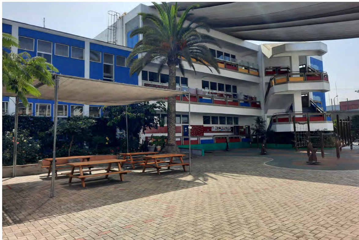
Ampliación de barra de aulas Figura 38. Fuente: Elaboración propia
