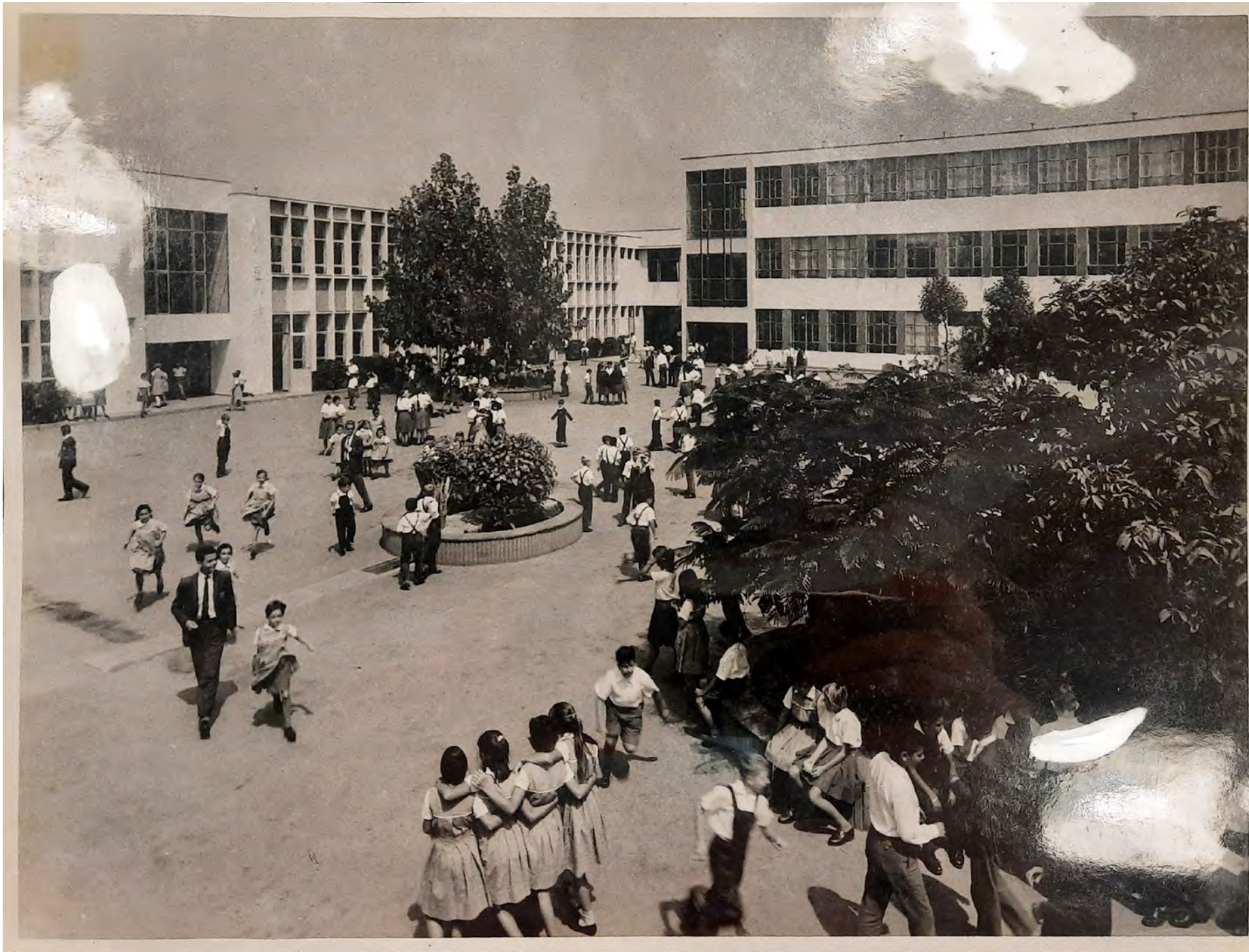
Imagen del patio principal del colegio Figura 19. Fuente: Archivo de Arquitectura PUCP
