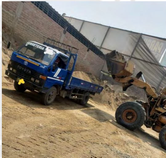
Figura 49: Carga imprecisa de arena
