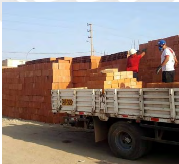
Figura 47: Trabajadores de la empresa con sus respectivos implementos de seguridad
