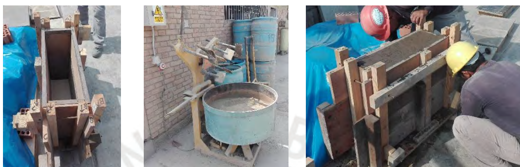
Figura 7. Encofrado de madera empleado, mezcladora vertical y resultado del vaciado
