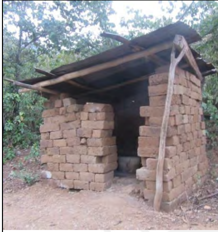
Foto n.º 17. Estructura de baños antiguos utilizados por la población.
