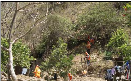
Foto n.º 37. Trabajos de campo.
