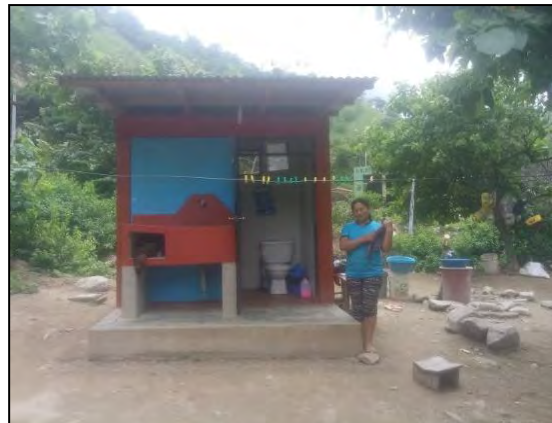
Foto n.º 11. Infraestructura culminada y utilizada por la propietaria Sra. Blanca Elena (beneficiaria).
