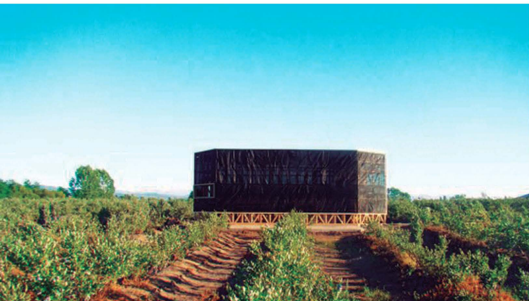
Figura 36. Vista exterior del Centro de Acopio
