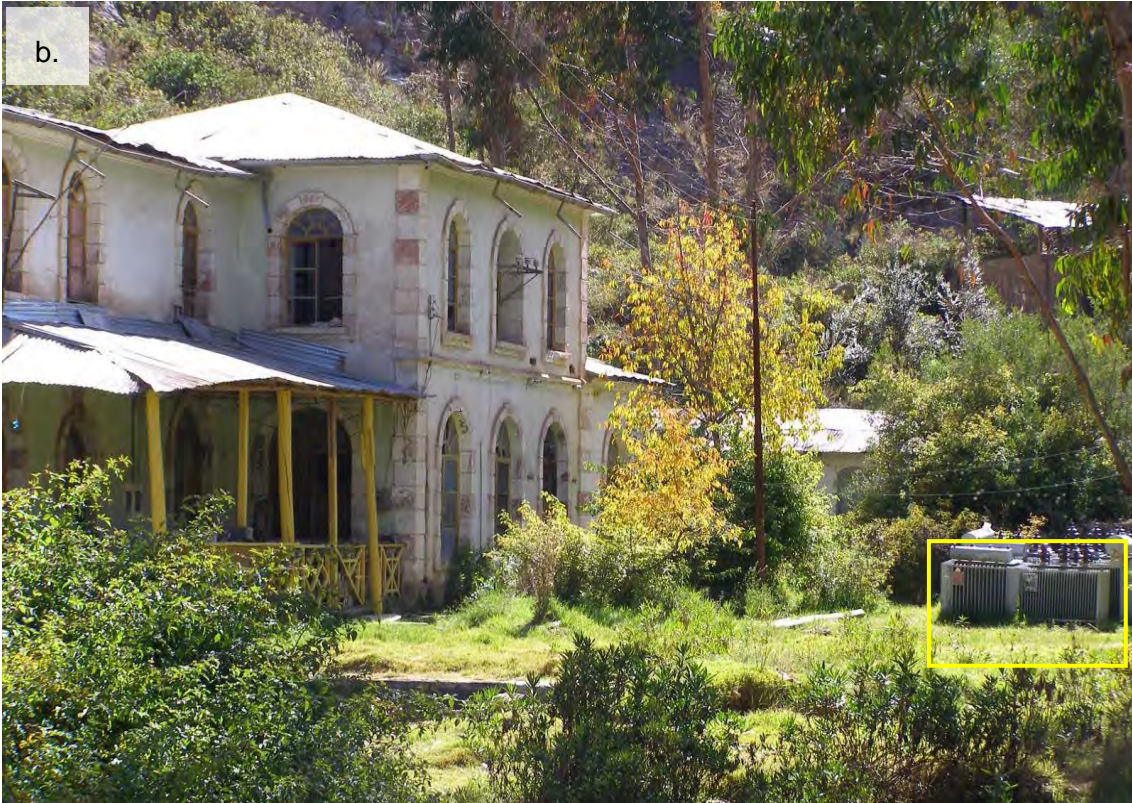
Figura 16 (a y b) área colindante a la central con transformadores (recuadros amarillos) ubicados sobre el suelo natural, 2010. Fuente: Neydo (2010: 2)
