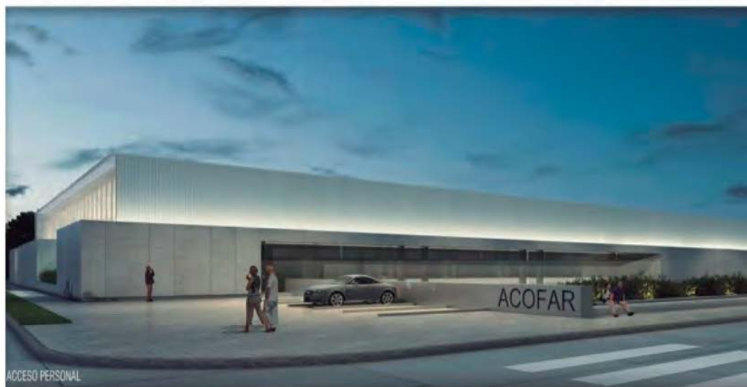
INTERIOR CENTRO DE DISTRIBUCION
