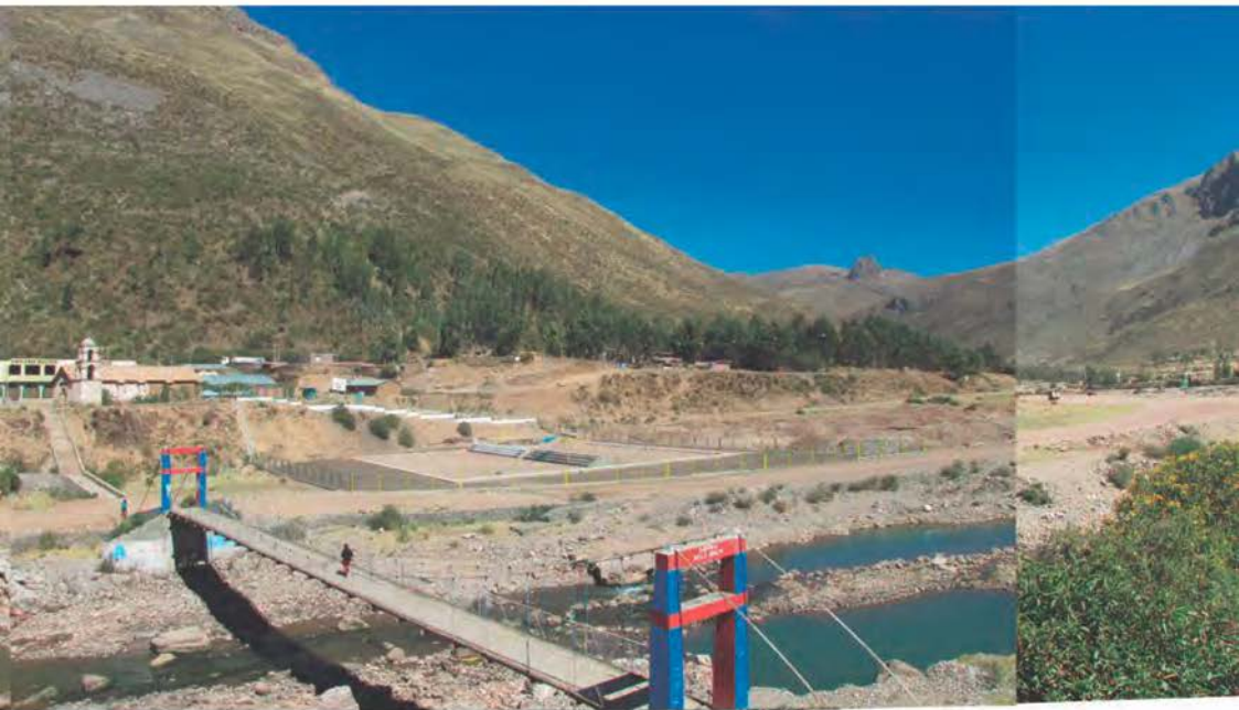
Puente peatonal conexion entre Callqui Chico -Callqui Grande
