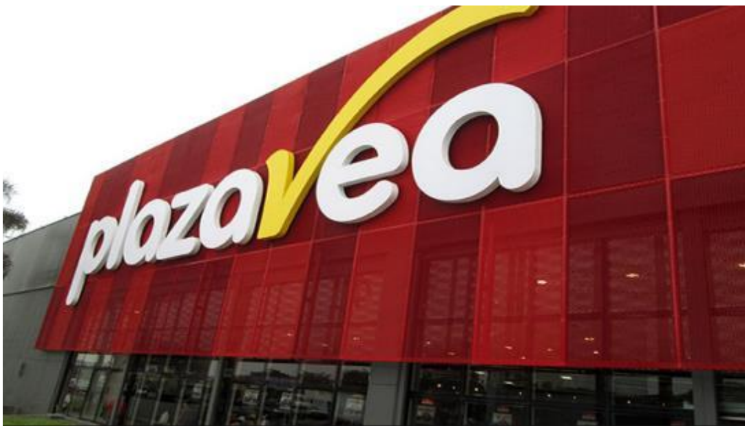
Figura 1. Local de SPSA “El Cortijo”. Tomado de “Molinari Arquitectos Asociados”. Recuperado de: http://www.molinari.cl/obras/plazavea.html
