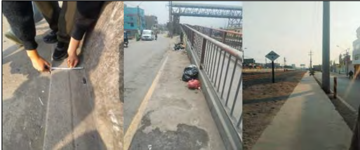
Figura 28: Veredas que conforman la intersección
