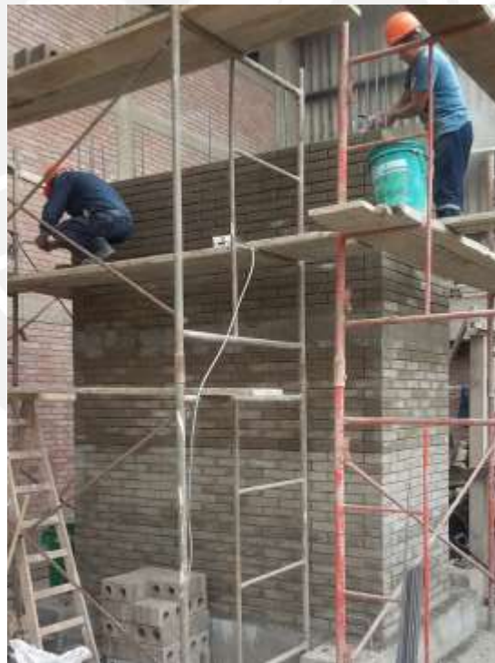
Fig. 6.10 Armado de los muros del segundo nivel.
