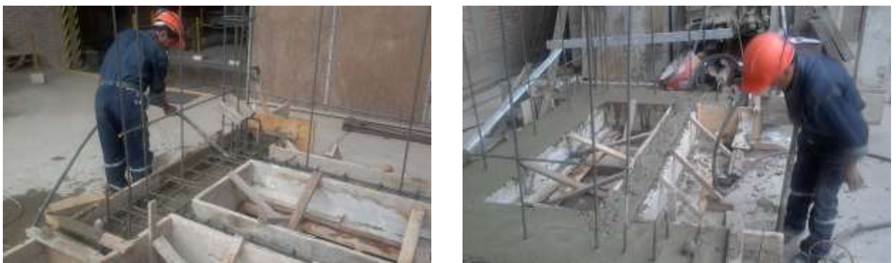
Fig. 6.4 Vaceado de la cimentación.
