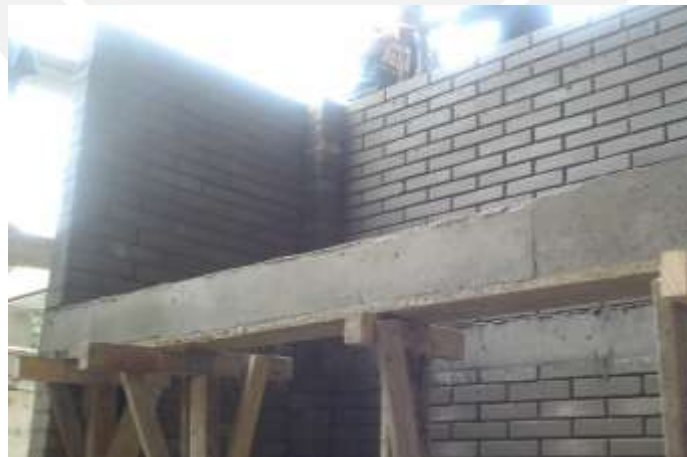
Fig.4.3. Viga solera del primer nivel.
