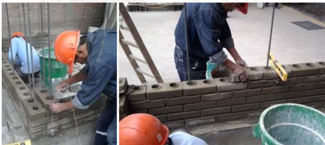
Fig. 6.7 Verificaciones de plomada y nivel.
