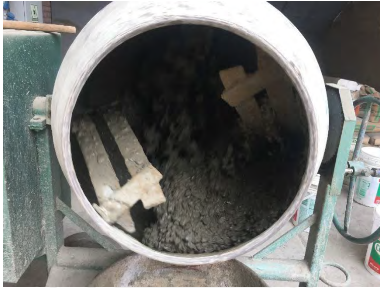
Foto A 5. Mezcla de agregados
