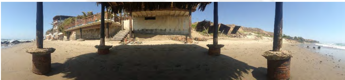
Figura 23. Erosión en Pocitas. Fuente: Fotografía tomada en la salida de campo.
