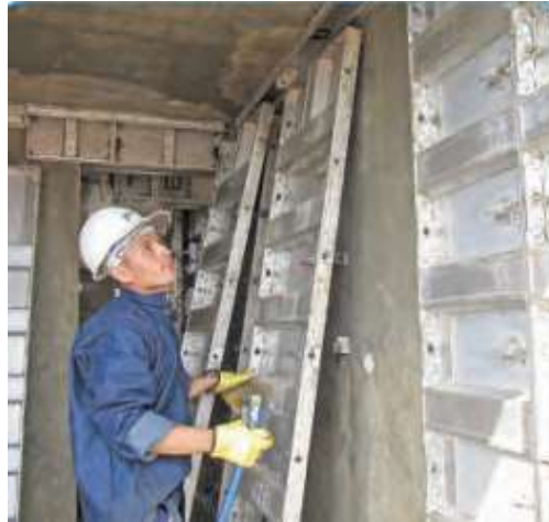
Fig. 32 – Desencofrado Paneles ( www.forsa.com.co , 2018)
