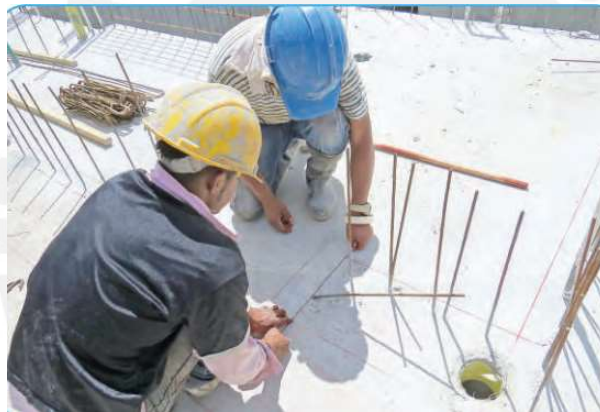
Fig. 18 – Trazo ( www.forsa.com.co , 2018)
