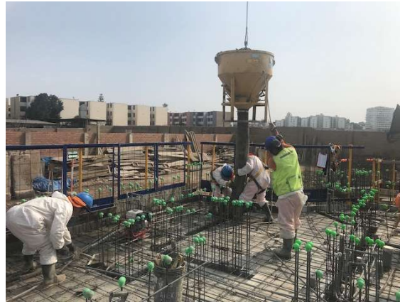
Fig. 45 – Colocación de Concreto (Fuente propia)
