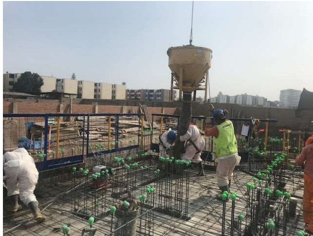
Fig. 63 – Concreto en Losa (Fuente propia)
