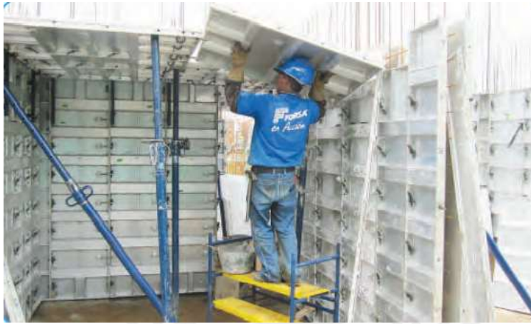
Fig. 29 – Montaje losa ( www.forsa.com.co , 2018)
