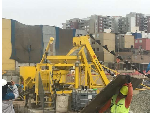
Fig. 42 – Mezclados Agregados (Fuente propia)
