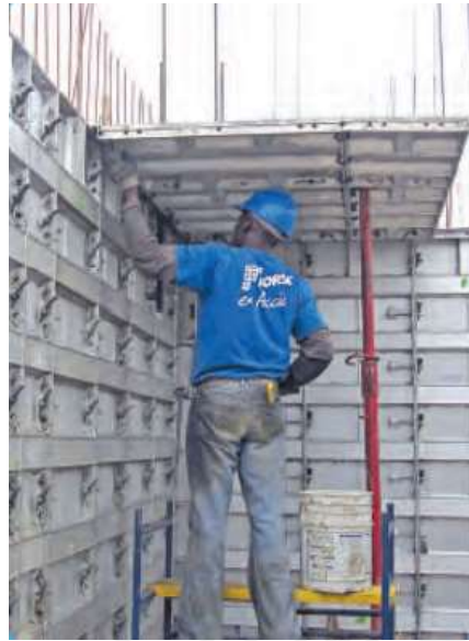
Fig. 27 – Montaje losa ( www.forsa.com.co , 2018 )
