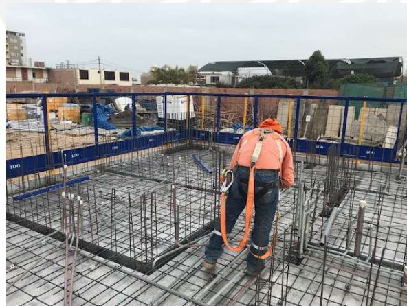
Fig. 30 – Instalaciones (Fuente propia)
