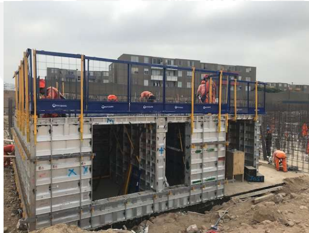
Fig. 31 – Encofrado Placas y Losa (Fuente propia)
