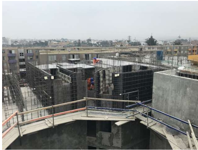
Fig. 59 – Encofrado (Fuente propia)
