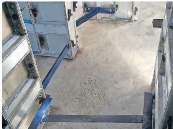
Fig. 23 – Tensores en Puertas ( www.forsa.com.co , 2018 )
