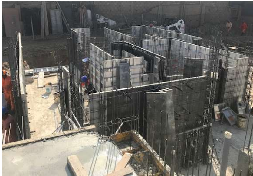
Fig. 21 – Montaje de Paneles (Fuente propia)
