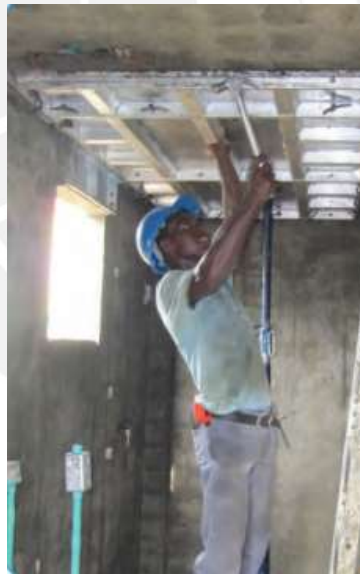
Fig. 33 – Desencofrado losa ( www.forsa.com.co , 2018 )
