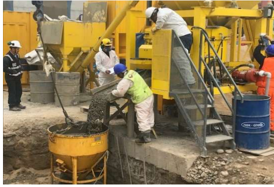
Fig. 43 – Descarga de Concreto (Fuente propia)
