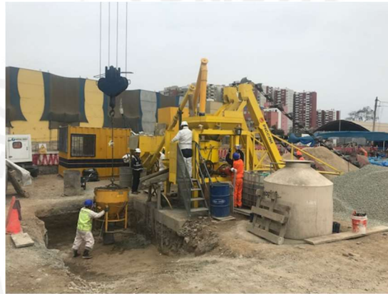
Fig. 44 – Transporte de Concreto (Fuente propia)
