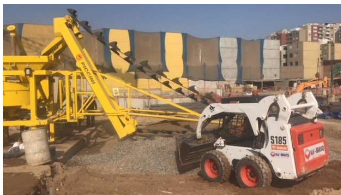
Fig. 41 – Movilización de Agregados (Fuente propia)
