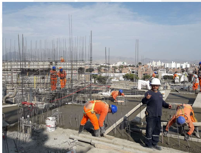
Fig. 64 – Acabado en Losa (Fuente propia)
