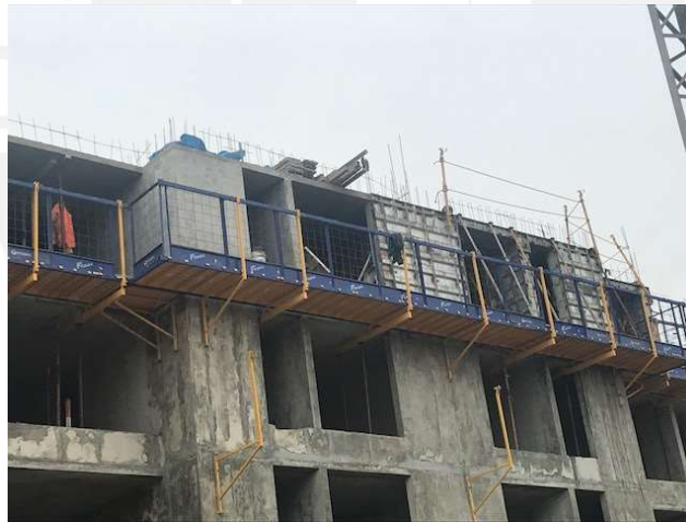
Fig. 58 – Desencofrado (Fuente propia)
