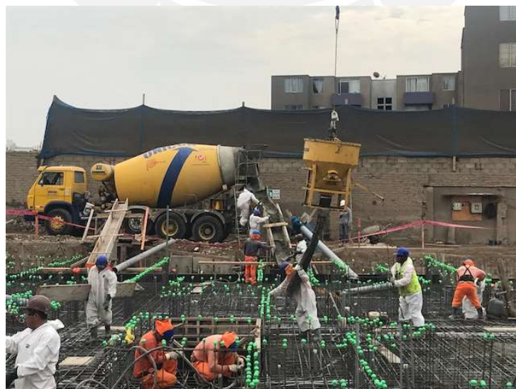
Fig. 07 – Colocación del concreto (Fuente propia)
