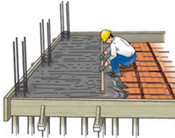
Fig. 06 – Colocación del concreto (Aceros Arequipa,2020)
