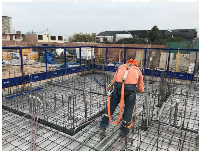
Fig. 60 – Acero en Losa (Fuente propia)
