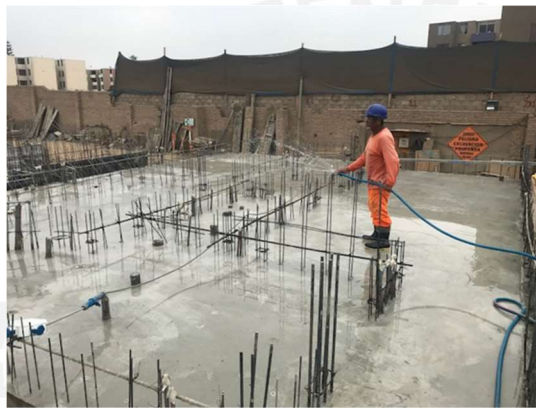
Fig. 47 – Curado de Concreto (Fuente propia)
