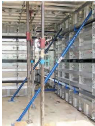
Fig. 24 – Tensores de Muros ( www.forsa.com.co , 2018 )
