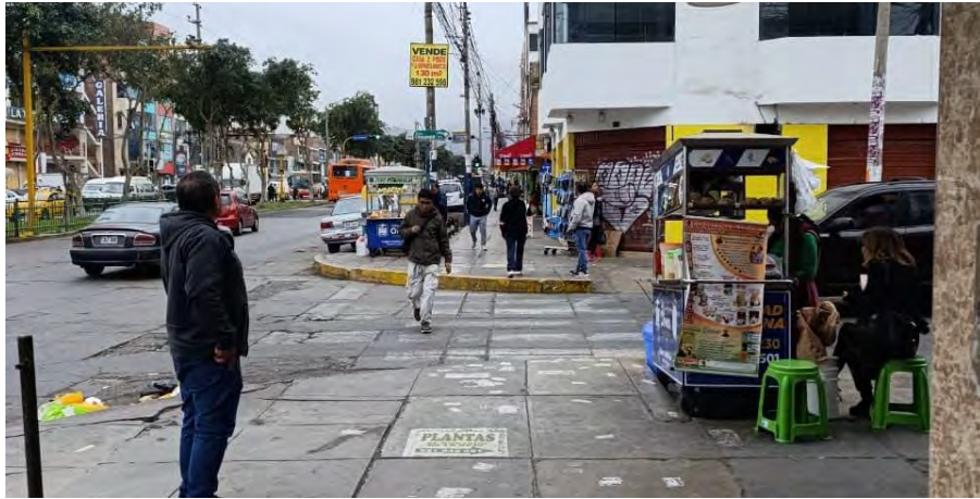
Figura 27. Intersección en T sin señalización horizontal ni vertical. Toma fotográfica propia.
