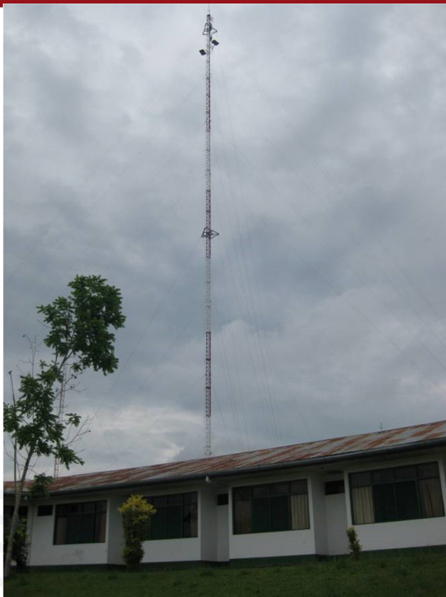
Gráfico 47: Vista de la torre ventada de 69m
