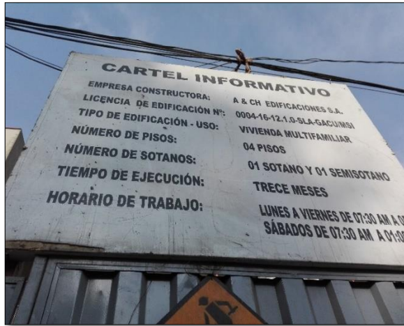
Figura 41: Verificación de un letrero informativo Fuente: Elaboración propia
