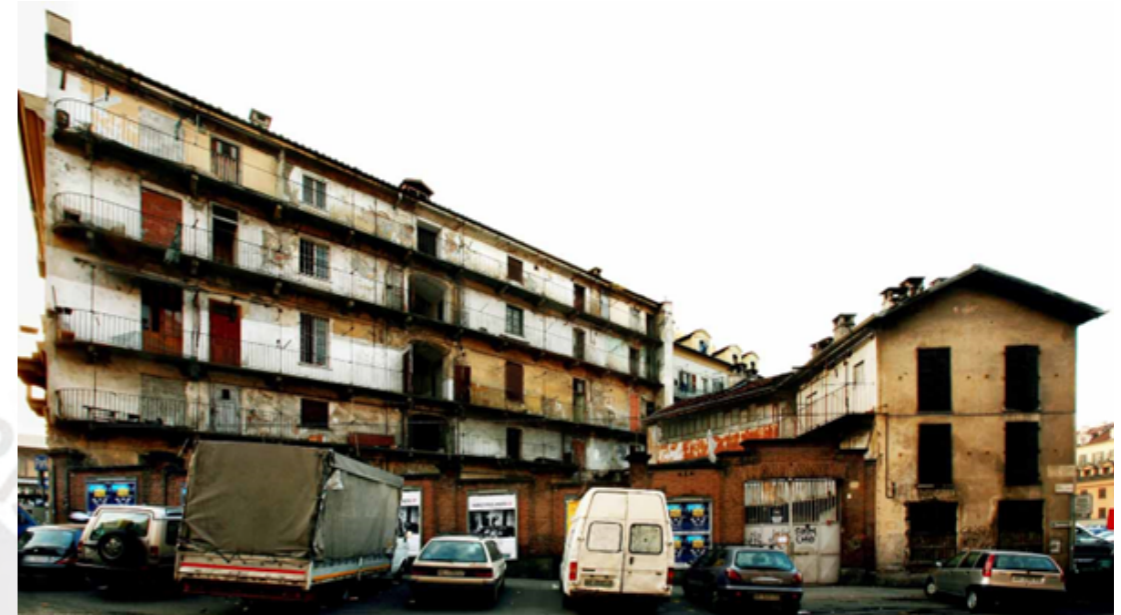
Figura 76: Residencia temporal antes de restauración Fuente: Guiding Architects 2024
