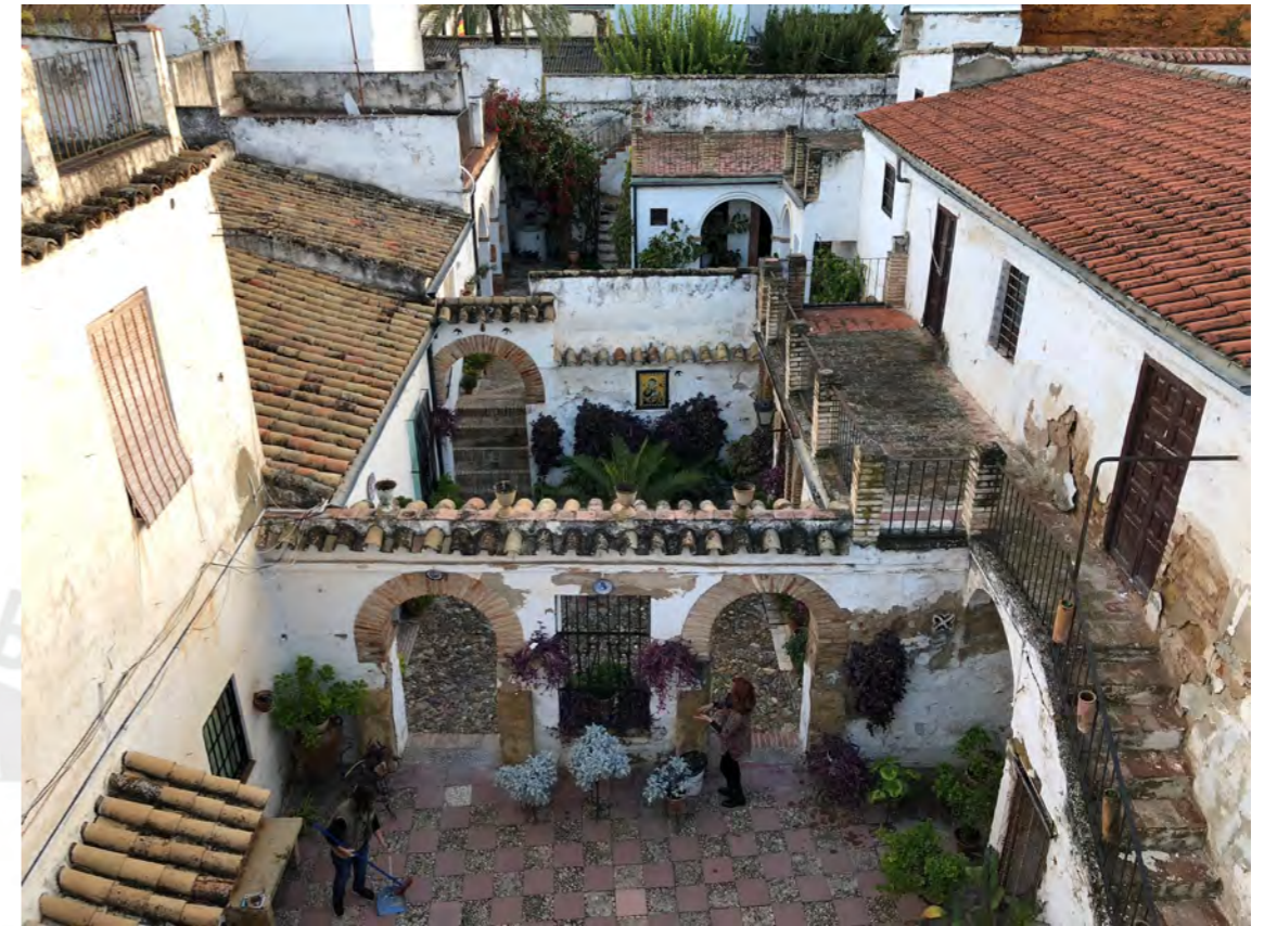
Figura 80: Patios antes de la intervención Fuente: Arquitectura viva 2024
