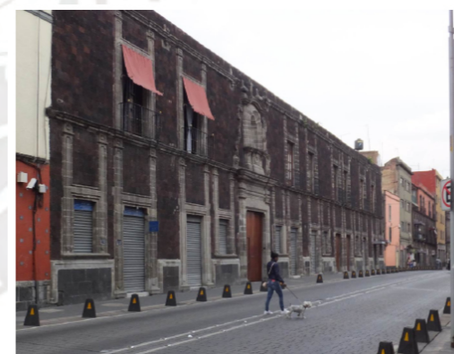
REHABILITACIÓN DE LA CASA DE LA COVADONGA
