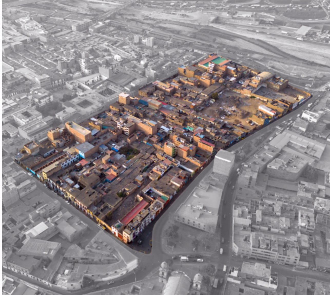
Estado Actual de la Manzana
