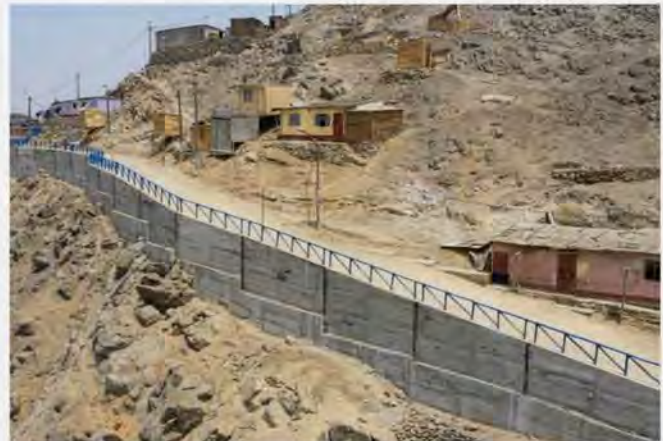
Construcción de muros de contención en zonas de alto riesgo. Tomado de la plataforma digital única del Estado Peruano.
