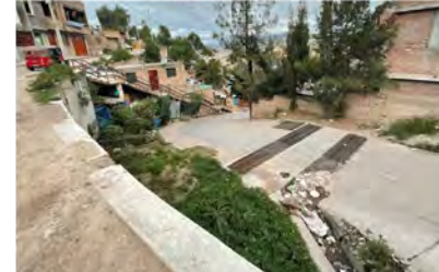
Drenaje pluvial subterráneo ⑥
