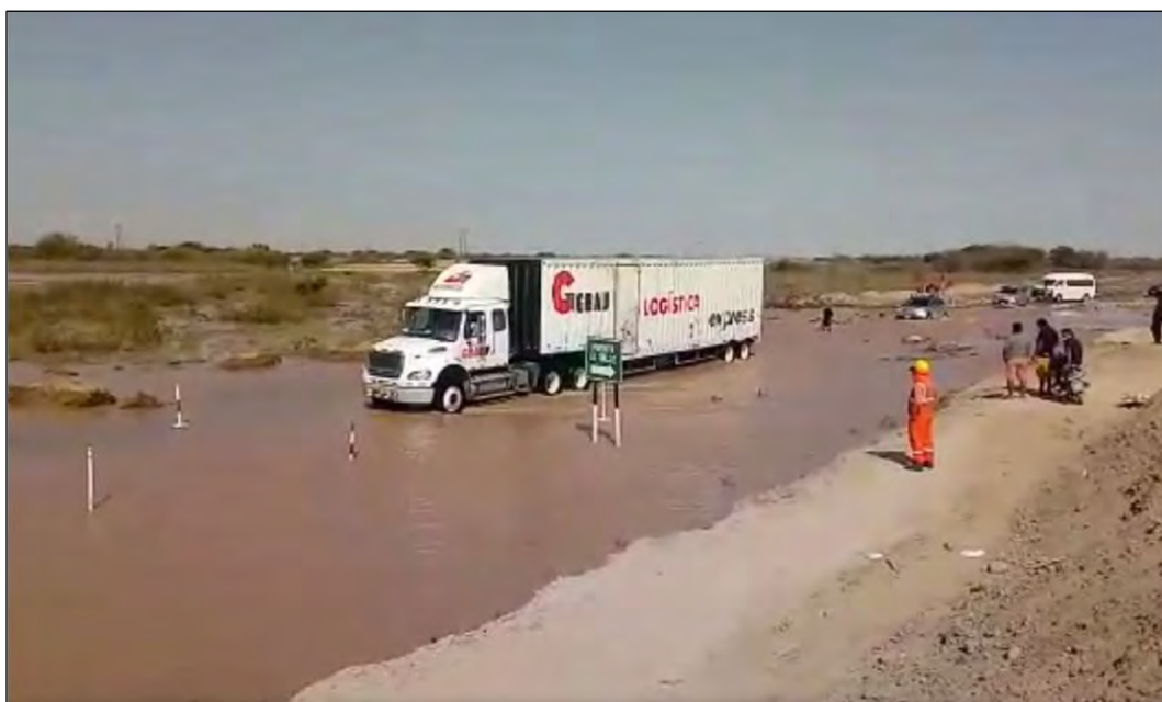
Figura 16. Daño longitudinal en la carretera Piura-Chiclayo posterior al daño
