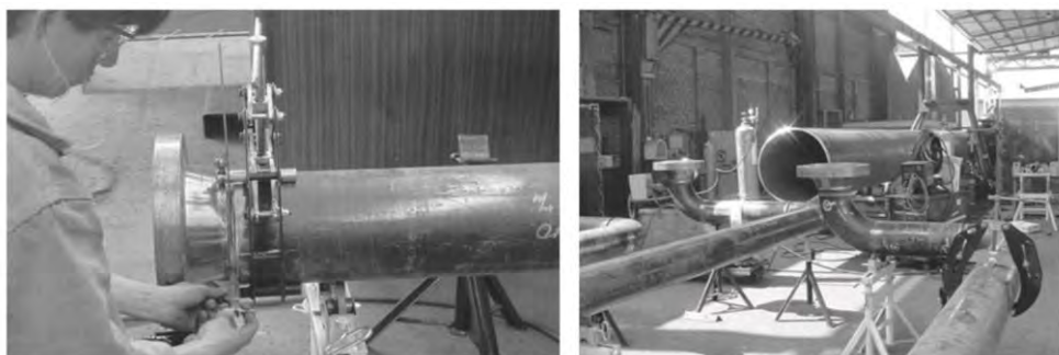
Figura 21. Armado de spools
