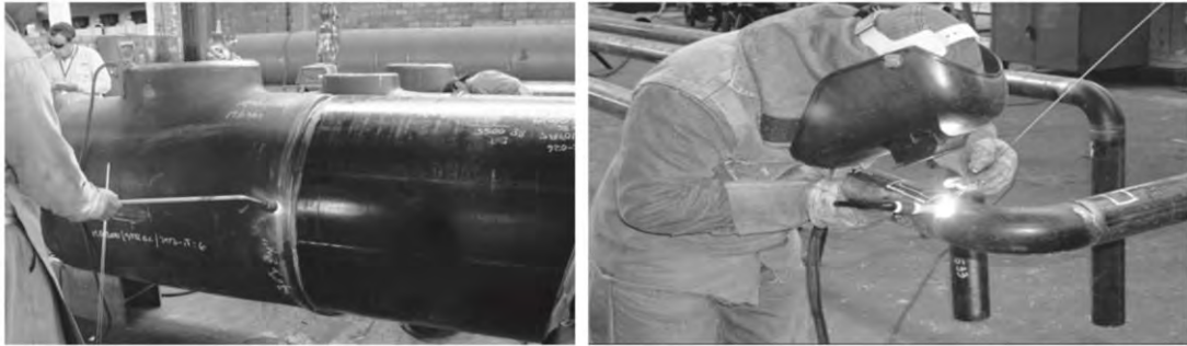
Figura 23. Soldadura de spools Fuente: Empresa de estudio.
