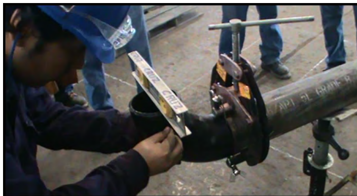
Figura 73. Armado de spools con sujetadores (clamps) Fuente: Empresa de estudio
