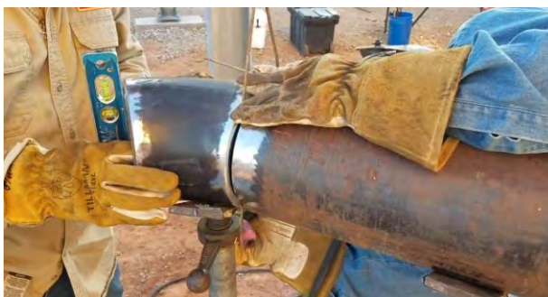
Figura 72. Armado de spools sin sujetadores (clamps)
