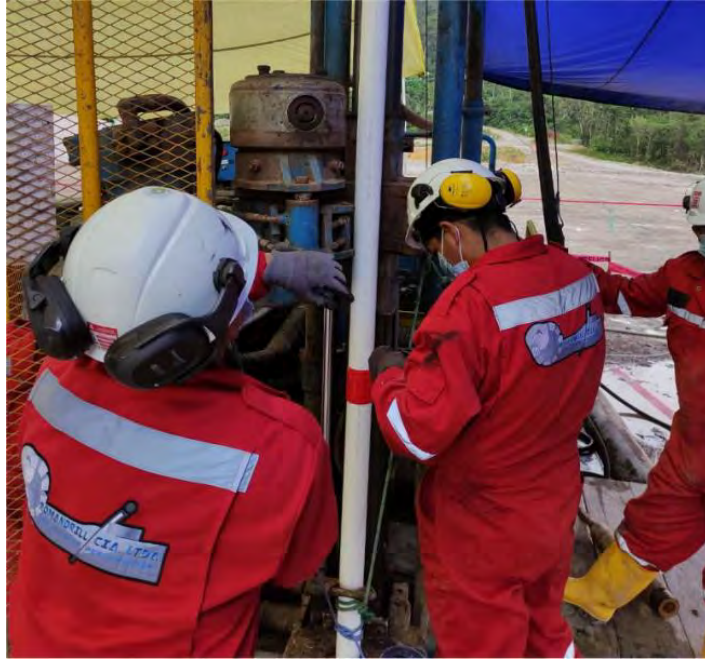
Figura 3-16 Instalación de un inclinómetro en La Presa (KCB, 2022)
