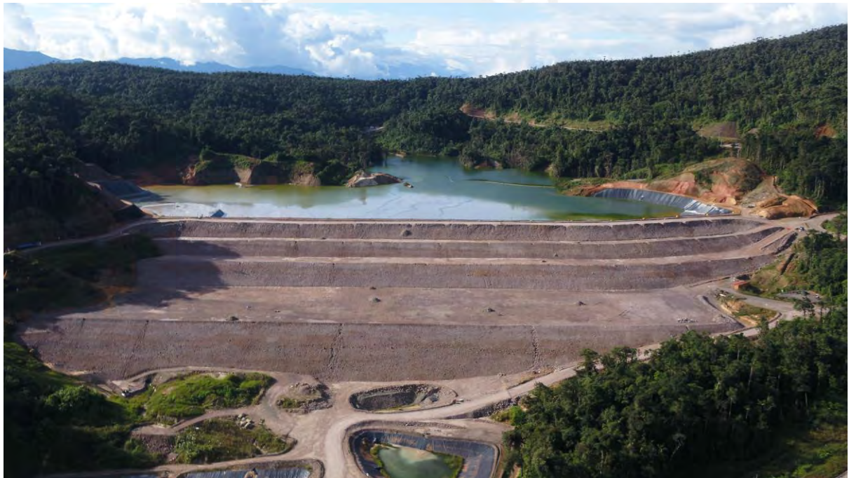
Figura 3-1 Foto de La Presa (KCB, 2021)
