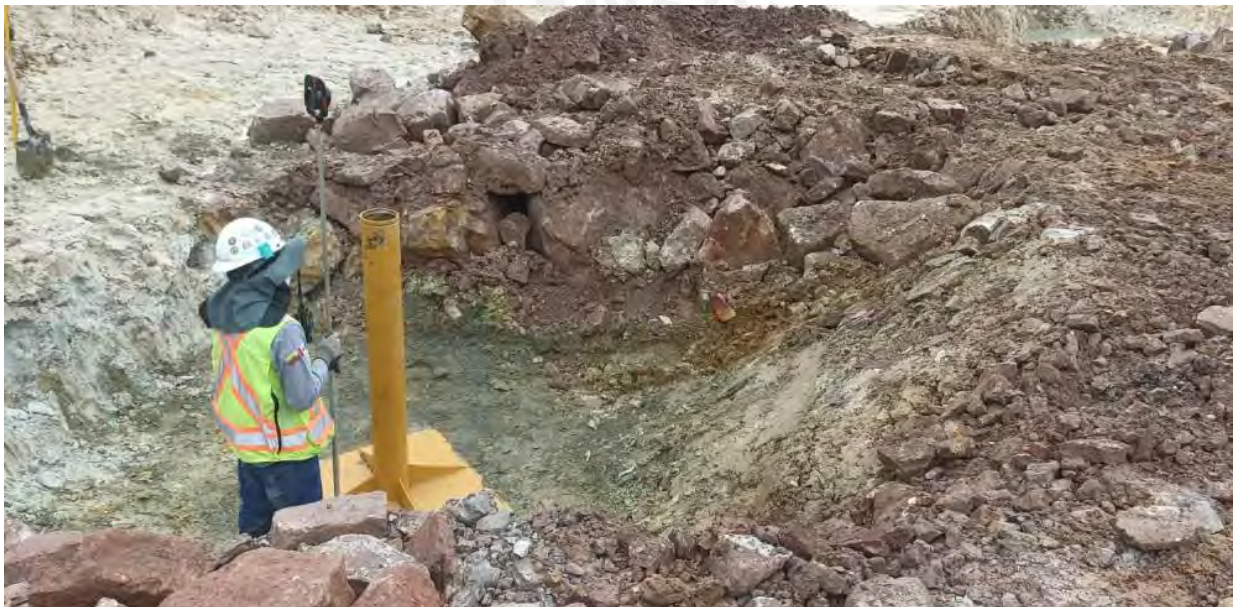
Figura 3-18 Instalación de una placa de asentamiento en La Presa (KCB, 2022)
