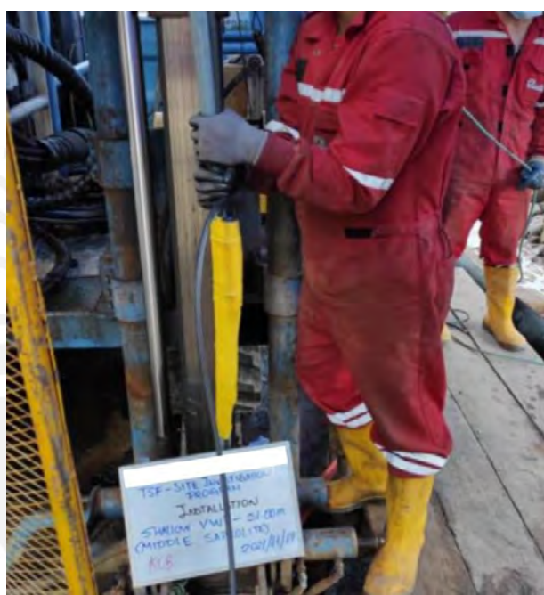
Figura 3-15 Instalación de un piezómetro en La Presa (KCB, 2022)
