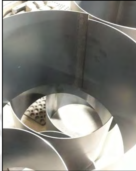
Figura 36: Soldadura longitudinal en tanque
