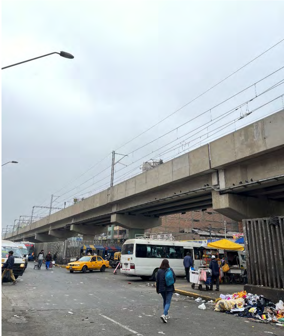
Figura 18: Presencia de acopio de basura en estación Gamarra. Fuente: Propia.
