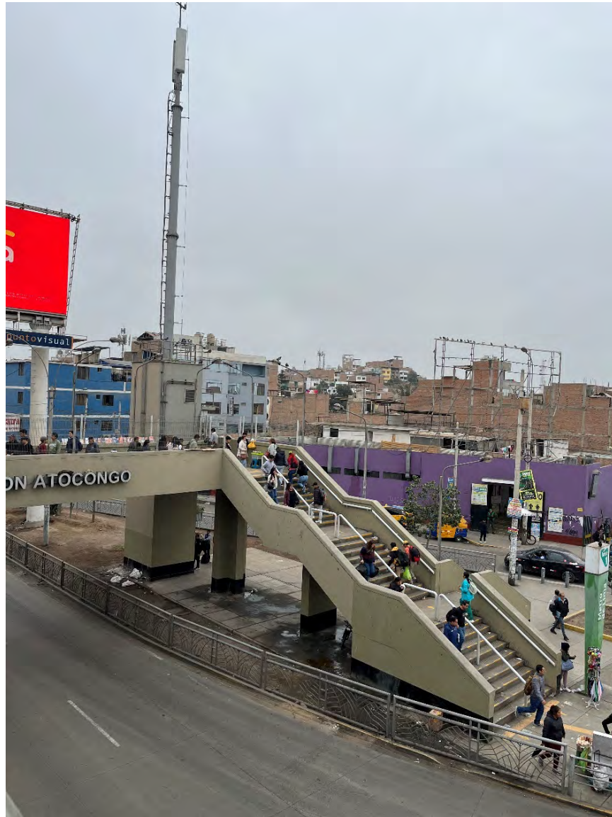
Figura 14: Calidad de áreas verdes en estación Atocongo. Fuente: Propia.
