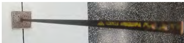
Fig. 18. Viga en voladizo de acero usada en este experimento.
