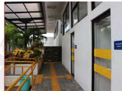
Infraestructura poco accesible Lo que genera preocupación en los padres al momento de enviar a sus hijos a sus centros de estudios para evitar accidentes
